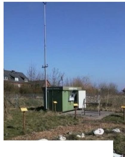
Moderne elektronische und vollautomatische Luftmess-Station
